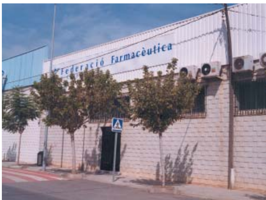
Almacén de la Federación Farmacéutica de Castellón en Almassora
