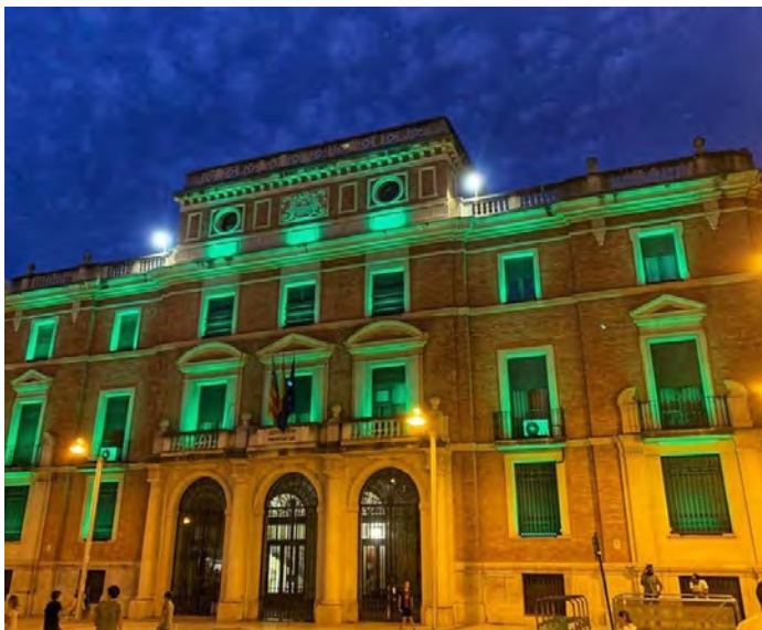
Fachada Diputación Provincial de Castellón.
